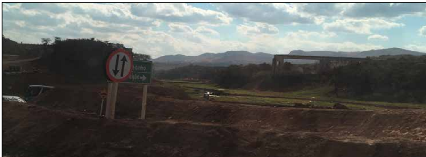
Ponte ferroviária quebrada ilustra os danos causados pelo colapso da barragem.
